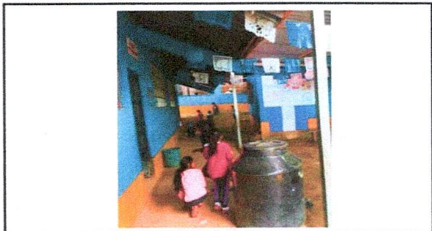
Foto 12: Sustitución de depósito de agua 1700lt
