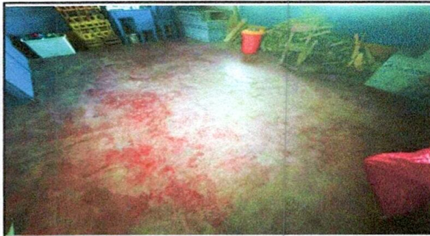
Foto 3: Sustitución del piso de torta de concreto.
