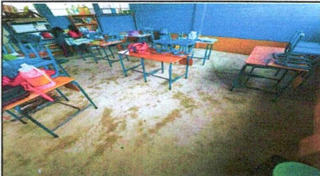
Foto 4: Sustitución de piso
