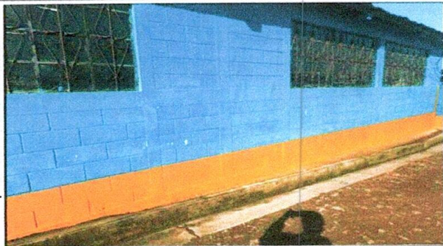
Foto 7: Aplicación de pintura en muros exteriores
