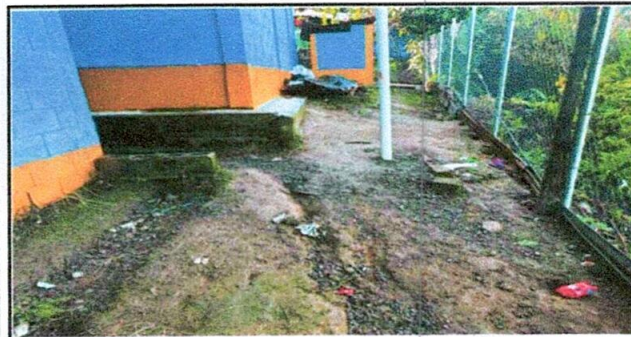
Foto 9: Reparación de losa de concreto
